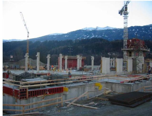
Fertigteilstützen, Fertigteilunterzüge, Schleuderbetonstützen
